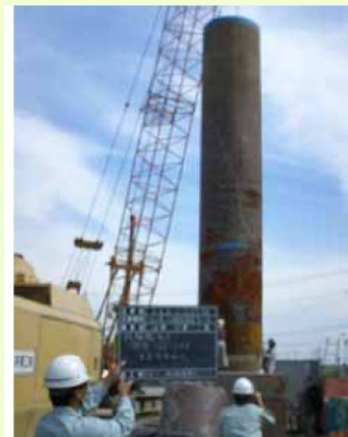
鋼管の建込み
